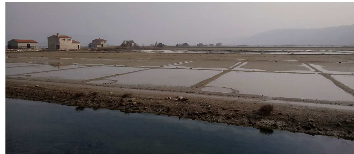
Stanje obnovljenega srednjeveškega solnega fonda 2021 (foto: Matjaž Kljun). Vidne so fosse, elementi za hitro spravilo slane vode, da je padavine ne razredčijo
