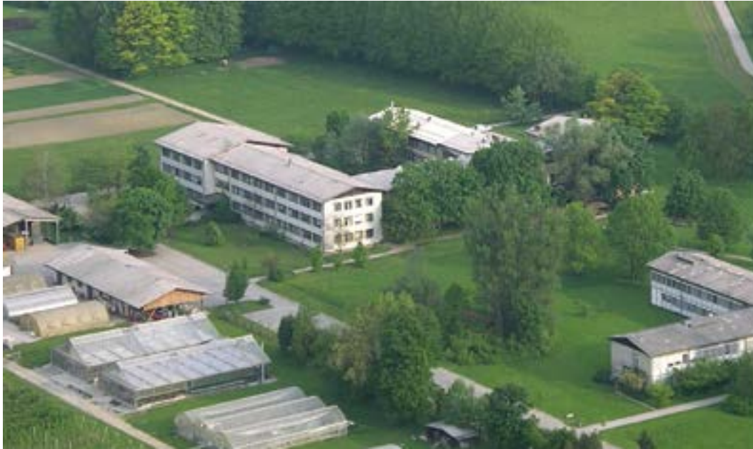
Velik kompleks pod Rožnikom je bil dodeljen Biotehniški fakulteti, da se tam zgradi Biotehniško središče.
